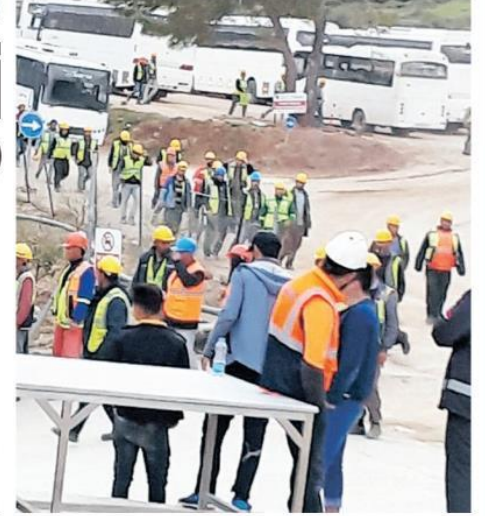
Yapımı devam eden Akkuyu Nükleer Santrali'de 5 binden fazla işçi çalışıyor.
